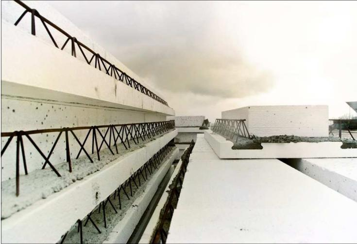
Le lastre Termodalle sono pannelli prefabbricati per solai precoibentati, costituite da travetti in calcestruzzo, contenenti le armature a copertura dei momenti positivi, ricavati nello spessore della lastra base in polistirene espanso, che intervallati ad opportuna distanza fra loro e con l'interposizione di elementi di alleggerimento, costituiscono la migliore risposta alle esigenze di un sempre migliore isolamento termico dei solai con un alleggerimento significativo del peso del manufatto.
