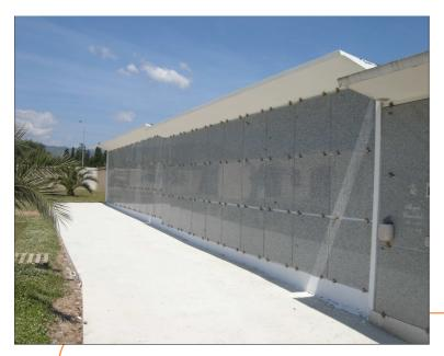
Sono moduli aventi struttura scatolare monoblocco realizzati in c.a.v..
