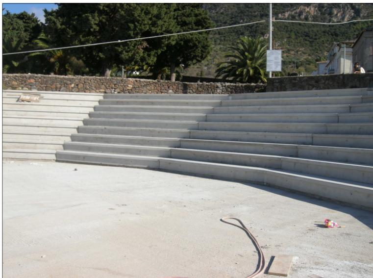
I gradoni prefabbricati sono delle travi a “L” in calcestruzzo armato vibrato per la realizzazione di qualsiasi genere di tribuna.
