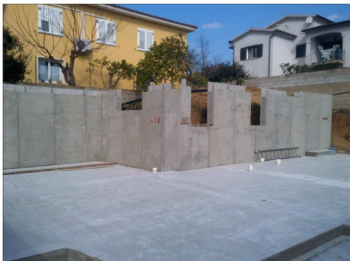
La doppia lastra è un elemento prefabbricato, costituito da due lastre in c.a. di spessore di c.a. 5 cm ognuna, poste ad una distanza reciproca tra i 20 cm ed i 40 cm collegate tra loro mediante tralicci elettrosaldati.
